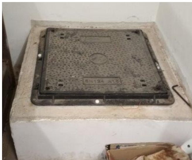
obr. /37/ Poklop revizní šachty není dostatečně těsný a dochází k úniku zápachu
