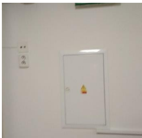
obr. /41/ Hlavní uzávěr elektrické energie
