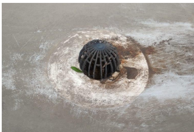
obr. /33/ Srážková voda z ploché střechy je odváděna do střešní vpusti
