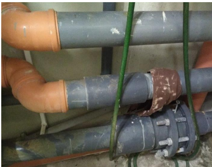
obr. /36/ Původní ležaté odpadní potrubí z polypropylenu
