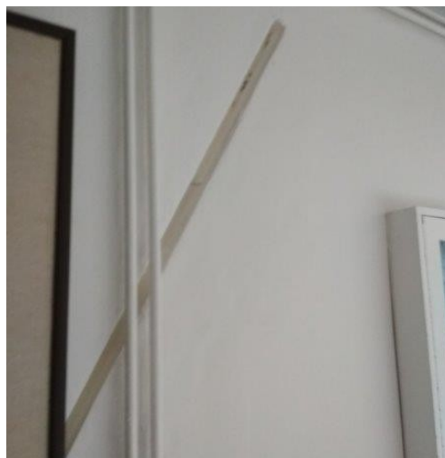
obr. /4/ Na stěně je dodatečně vytvořena dilatační spára
