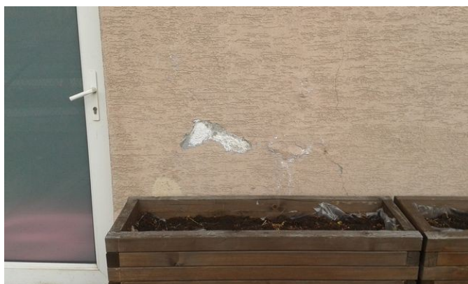
obr. /9/ Lokální mechanické poškození fasády
