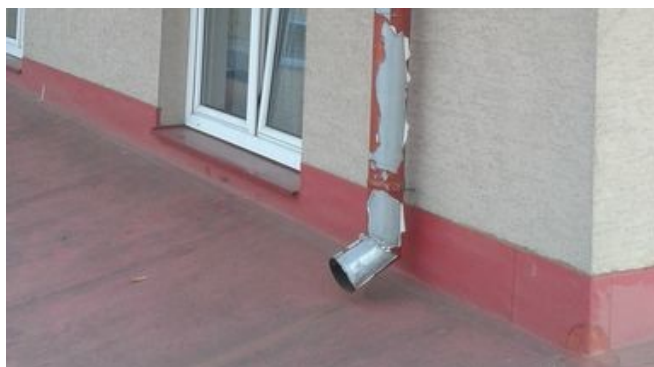
obr. /31/ Ze střešní roviny nad druhým nadzemním podlažím je srážková voda pomocí střešních svodů vedena na střešní rovinu nad prvním nadzemním podlažím
