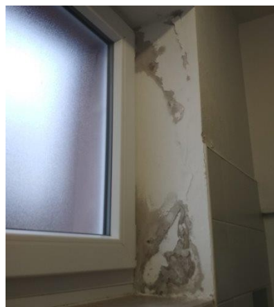
obr. /6/ Na ostění okna na chodbě k bazénu dochází s největší pravděpodobností ke kondenzaci na vnitřním povrchu
