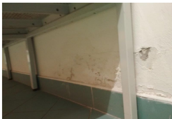
obr. /10/ Vlhkostní projevy na stěně pod lavičkami v šatnách
