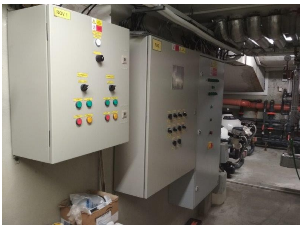
obr. /45/ Zdrojem vytápění objektu je výměňíková stanice umístěna v suterénu
