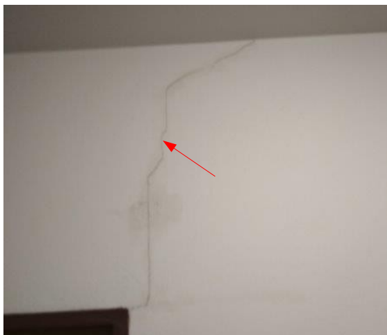
obr. /11/ Trhlina vznikající v místě dveřního otvoru pokoje pro hosty
