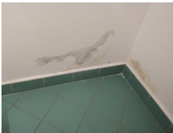
obr. /5/ Na stěnách vznikají vlhké mapy – pravděpodobně průsak netěsností sprchových koutů z druhé strany stěny
