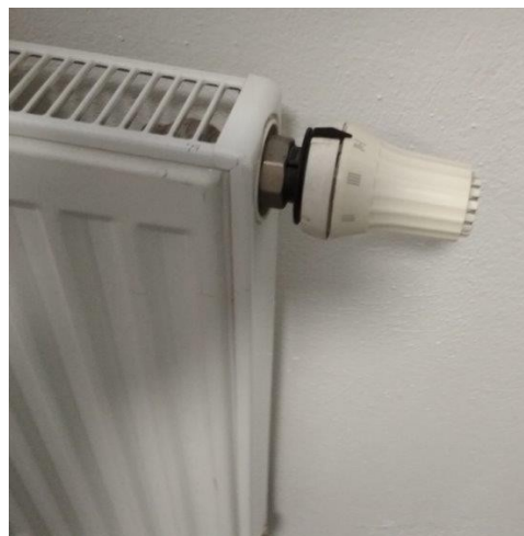
obr. /44/ Radiátory jsou doplněny termostatickými hlavicemi
