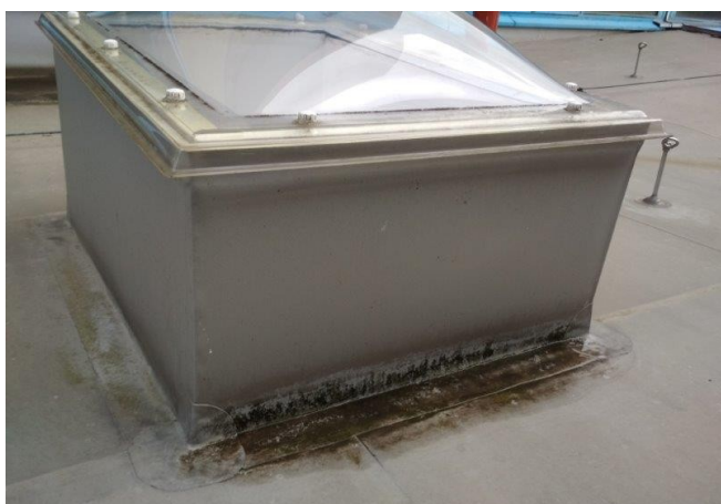
obr. /32/ Před střešními světlíky se nenachází rozháňka ve spádu střešní roviny
