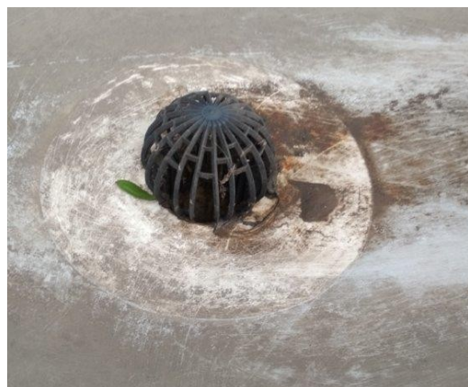
obr. /48/ Střešní vpust' je chráněna plastovým ochranným košíkem.
