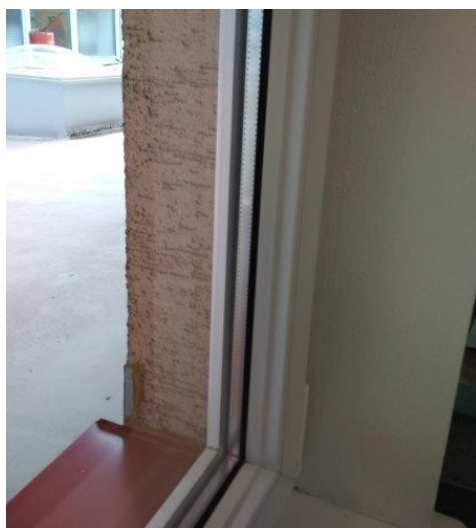
obr. /17/ Izolační dvojsklo je lemováno hliníkovým distančním rámečkem
