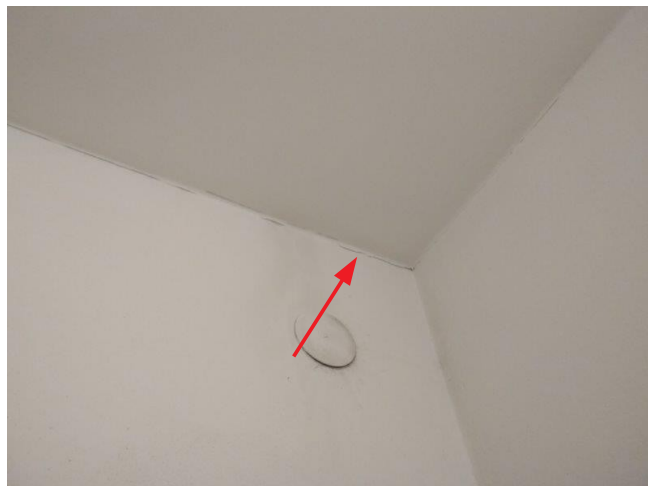
obr. /12/ Trhlina v místě styku vnitřní stěny a podhledu
