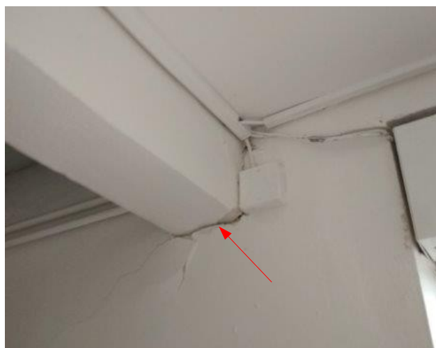
obr. /14/ Trhlina v místě uložení stropního průvlaku
