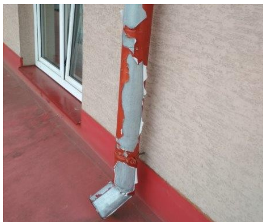
obr. /34/ Ochranný nátěr svodu je zdegradovaný obr. /35/ Spád oplechování je v některých částech objektu pouze 1^\circ
