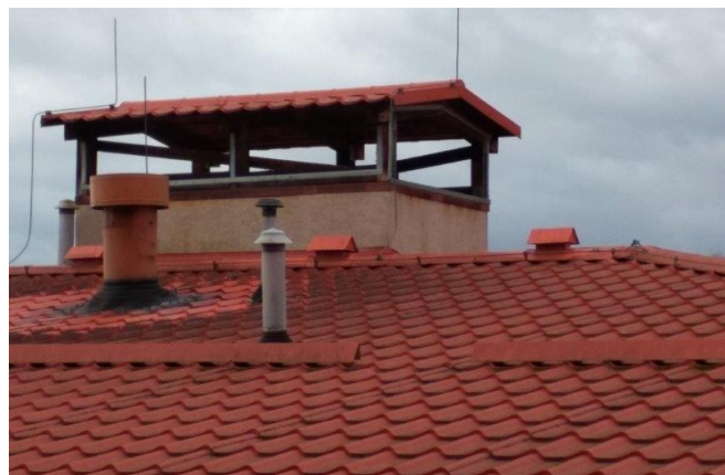
obr. /29/ Střešní rovina nad druhým nadzemním podlažím je doplněná systémem protisněhových zábran
