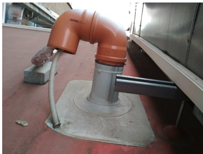
obr. /24/ Prostup pro protažení kabeláže na ploché střeše
