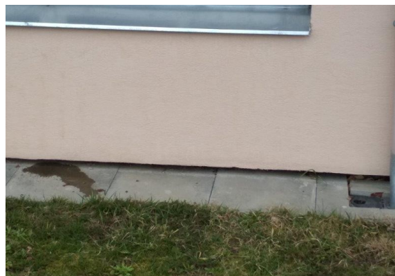
obr. /22/ Stav okapového chodníčku z betonových dlaždic odpovídá době jeho realizace
