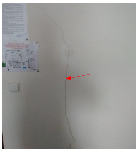
obr. /13/ Trhlina vznikající ve stěně pokoje pro hosty
