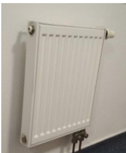
obr. /43/ Původní deskový ocelový radiátor
