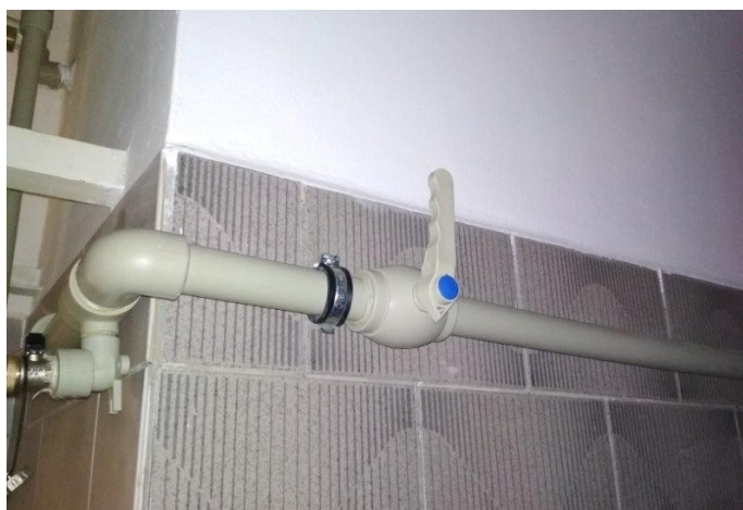
obr. /38/ Rekonstruované části vodovodních rozvodů jsou vedeny v potrubí z polypropylenu
